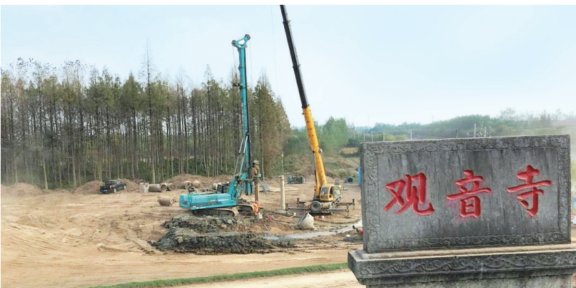
这是施工人员正对荆江大堤观音寺间进行拆除开挖施工的一个画面。荆江大堤观音寺间位于荆江大堤桩号740+750处,是一座由新老闸组成的套闸,经多年运行存在不少安全隐患,江陵县为此成立指挥部,对观音寺间进行全面重建。(秦为光 摄)
