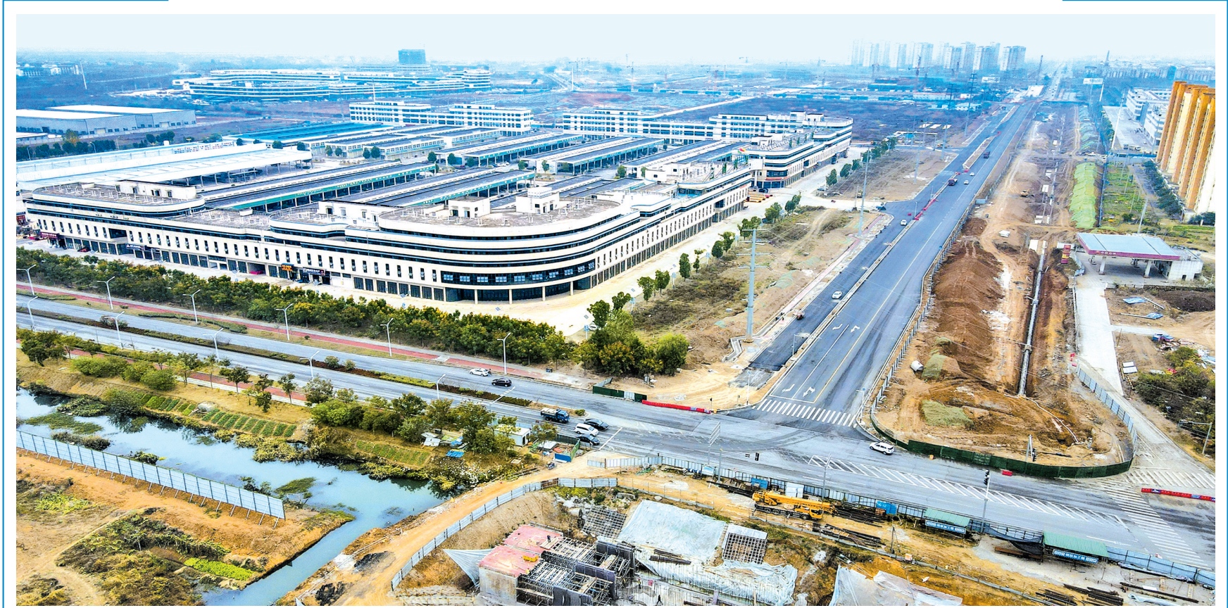
日前,航拍位于荆州高新区的复兴大道西延线项目施工现场,太湖大道至玉石路段部分车道已经通车。复兴大道西延线东起玉石路连接引江济汉渠桥,西至黄台路,全长2764米,设计时速主线部分为60公里每小时、辅道为40公里每小时,线路建成通车后将与已建成的复兴大道主线连接贯通,将进一步完善路网布局,为塑造大城市骨架奠定基础。 (潘路 张梦瑶 摄)
