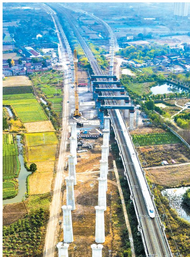
11月22日凌晨,中铁十二局建设者经过连续4小时施工,新建荆(门)至荆(州)铁路江汉运河2号特大桥第5次跨汉宜线钢盖梁施工安全完成,标志着荆荆铁路全线钢盖梁门式墩吊装施工全部完成,为后续架梁、铺轨施工创造了有利条件。荆荆高铁建成通车后,湖北将实现“市市通高铁”。(张梦瑶 郇欣 李晚晖 摄)
