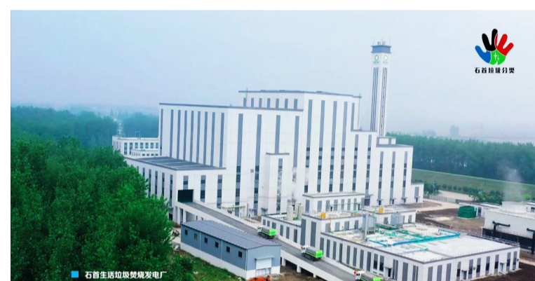
石首市生活垃圾焚烧发电厂于2021年3月正式投产。
