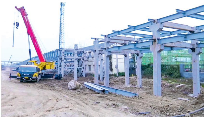
江陵经济开发区综合管廊工程(一期)是与华鲁恒升项目配套的重要基础设施,于2022年6月启动建设。目前,项目建设进展顺利,已完成工程量的90%,预计今年6月底可全线移交使用,满足企业货物及产品运输需求。(杨小红 摄)
