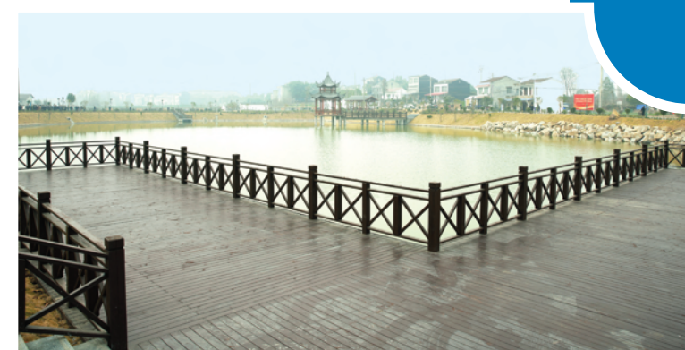
团山寺镇东南入口桥头游园。
