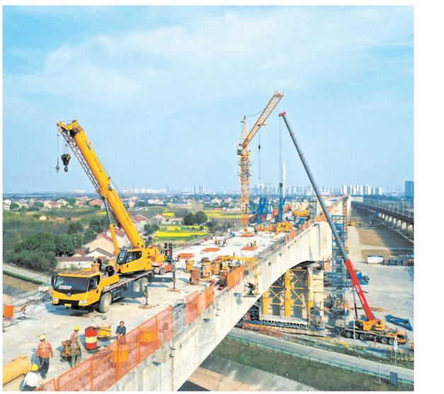
3月12日,在荆州铁路4标段中铁12局项目工地跨江汉运河连续梁拱桥工地,已完成拱桥梁部结构全部施工任务,正在搭设拱架,预计5月底可成桥。(叶力铭 梅闻 郇欣 摄)
