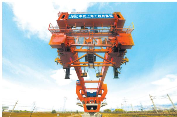
5月5日拍摄的包银高铁跨万甘铁路特大桥梁架梁施工现场。当日,由中铁上海工程局承建的包(头)银(川)高铁跨万甘铁路特大桥梁架梁架梁任务完成,标志着包银高铁内蒙古段首座跨铁路特大桥梁主体工程结束。跨万甘铁路特大桥梁全长2526.8米,设计共78孔预制箱梁,箱梁架梁任务的完成为后续铺轨奠定了坚实基础。包银高铁是我国“八纵八横”高速铁路网京兰通道的重要组成部分,设计时速250公里。(新华社发)
