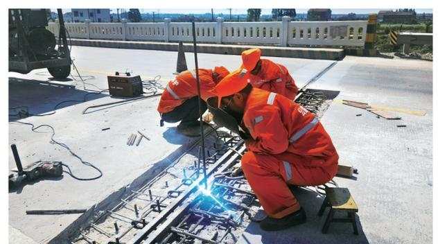
351国道东干渠桥上,公路养护人员正对损坏的桥梁伸缩缝进行修复。连日来,公安县公路事业发展中心全力以赴提升安全设施精细化水平,集中清理路面坑槽、沉陷等病害,切实加强桥梁养护管理,多措并举按下公路养护提质三年攻坚战“快进键”,全力推进全县普通公路高质量发展。(魏文娟 摄)
