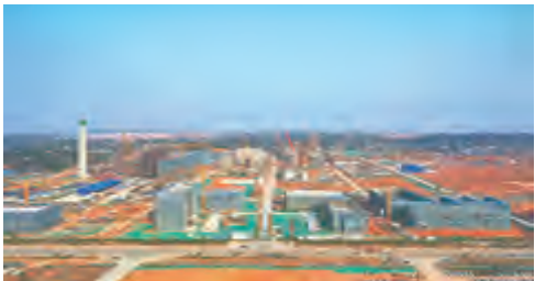
加速建设中的宜化氢醇项目。
