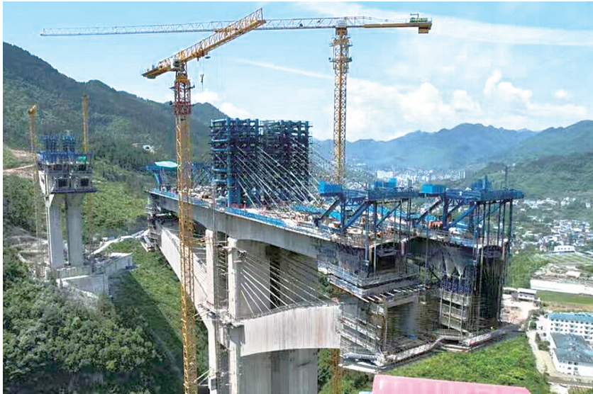
6月5日,在云南庄特大桥施工现场,工程建设如火如荼。
