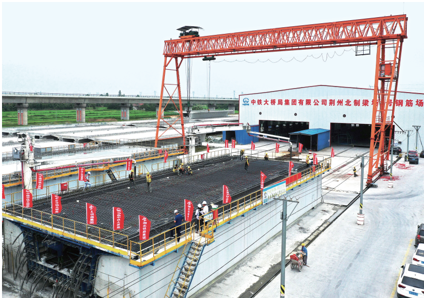
6月3日,荆荆铁路3标项目最后一榀箱梁完成浇筑。
