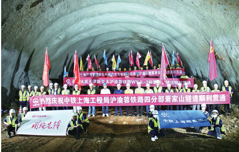
5月14日,沪渝蓉高铁武宜段WYZQ-3标萧家山隧道顺利贯通。
