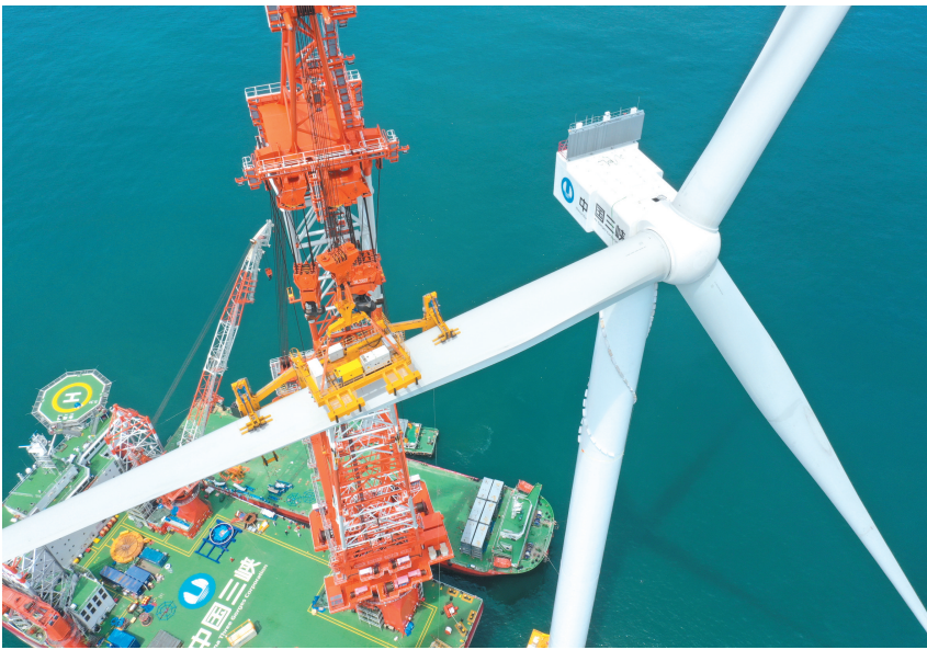
6月28日拍摄的全球首台16兆瓦海上风电机组吊装现场。(新华社 发)
