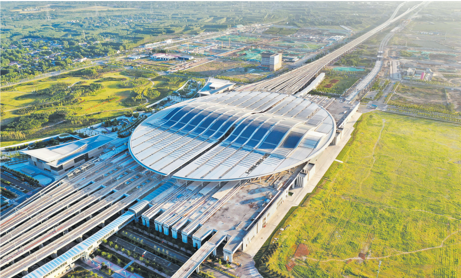
这是雄安站（6月2日摄，无人机照片）。雄安站位于雄安新区容尚片区，是雄安新区开工建设的第一个重大基础设施项目，具有标志性意义。（新华社 发）
