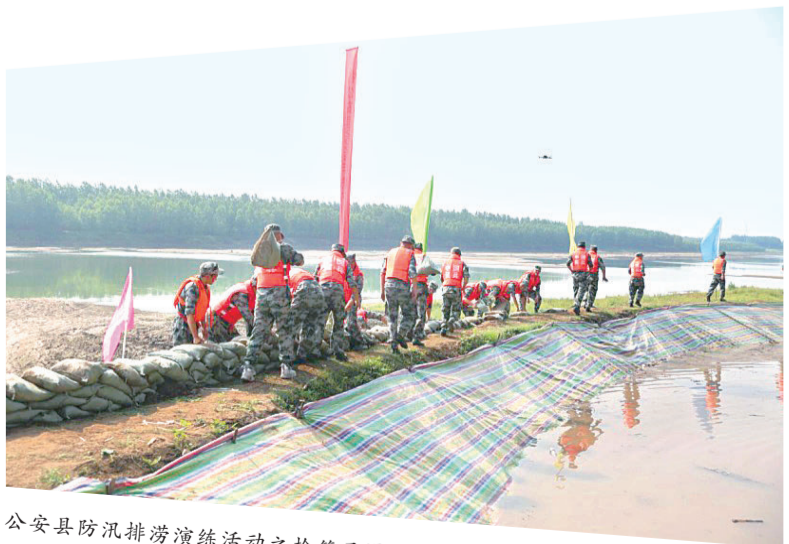
公安县防汛排涝演练活动之抢筑子堤。
