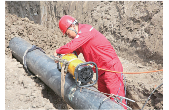
“天然气管道泄漏”事件应急处置应急演练现场。
