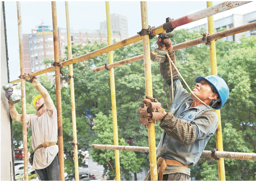
近日,沙市区长港路蛇入山菜场旁,一餐馆幕墙正全面“美容”,多名建筑工人顶着烈日高温搭建脚手架,为城市建设默默奉献。(梅闻 摄)
