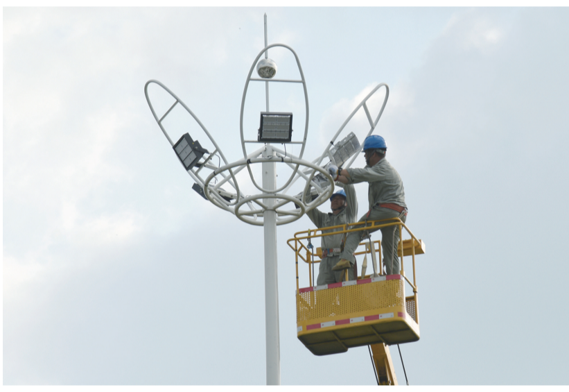
日前,在荆州古城东门外金凤广场,市路灯管理服务中心工作人员进行高空路灯维护作业。烈日下,路灯人坚守岗位,穿梭于大街小巷,确保夜间照明设施正常运转。(潘路 摄)
