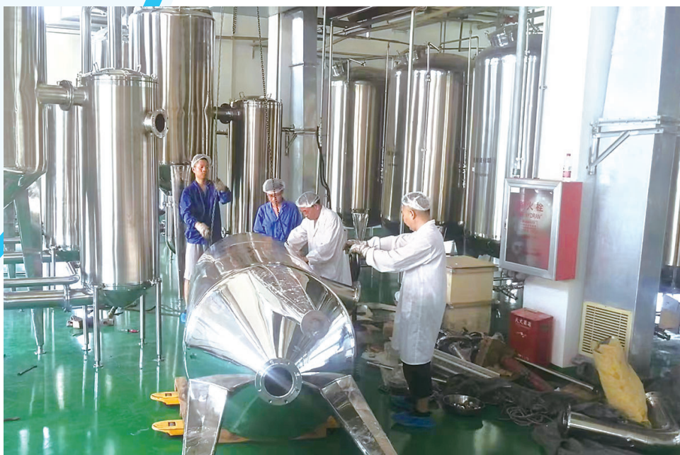
梦阳药业前处理提取车间技改现场。(马大军 摄)
