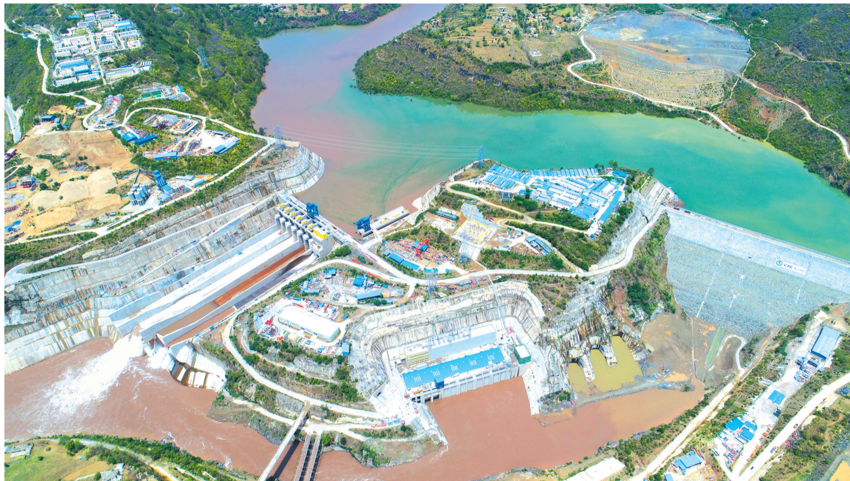
这是在巴基斯坦旁遮普省拍摄的中巴经济走廊水电投资项目卡洛特水电站(2022年6月22日摄,无人机照片)。(新华社发)
