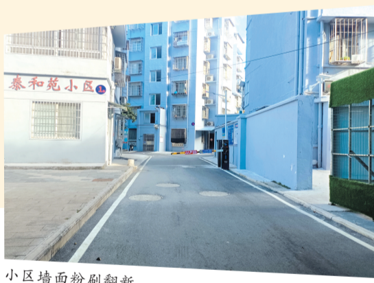
小区墙面粉刷翻新。
