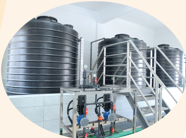
松滋市库家咀水厂絮凝剂储罐正在运行。
