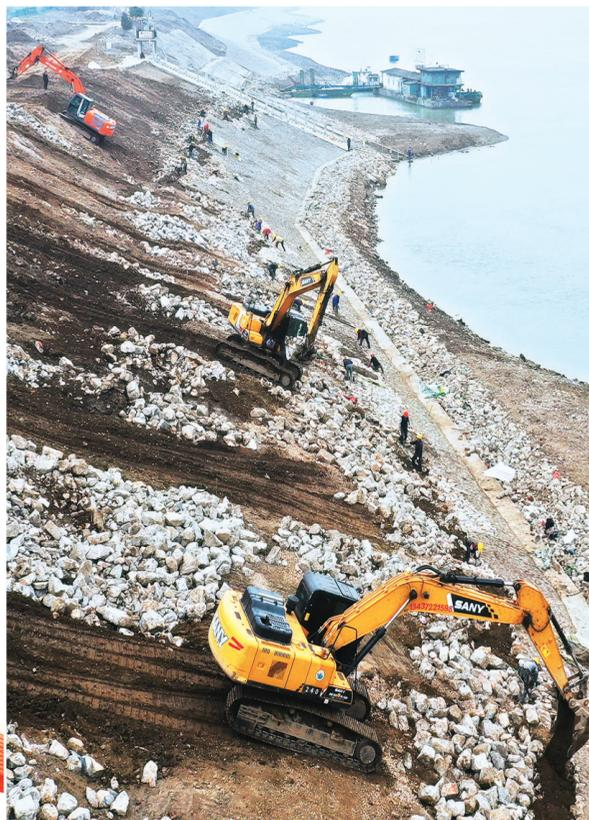
◀3月6日,长江沿线沙市洋码头段,项目部正在实施长江护坡修复工程。年前,该段面已完成水下抛石加固工程,目前正在开展混凝土挡土墙施工,预计4月底可全面完成。(梅 闻 吕诗洋 摄)
