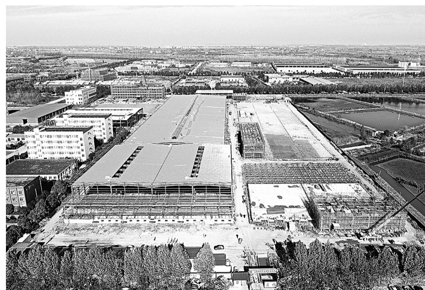
佳园禄项目建设现场。
