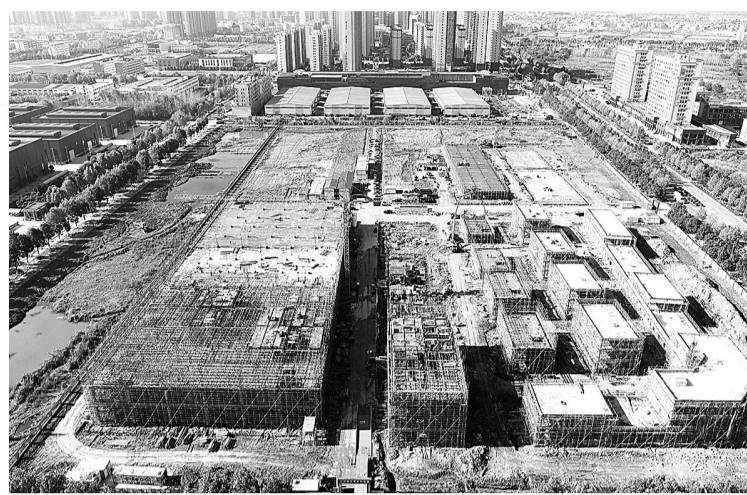
瀚城智谷项目建设现场。
