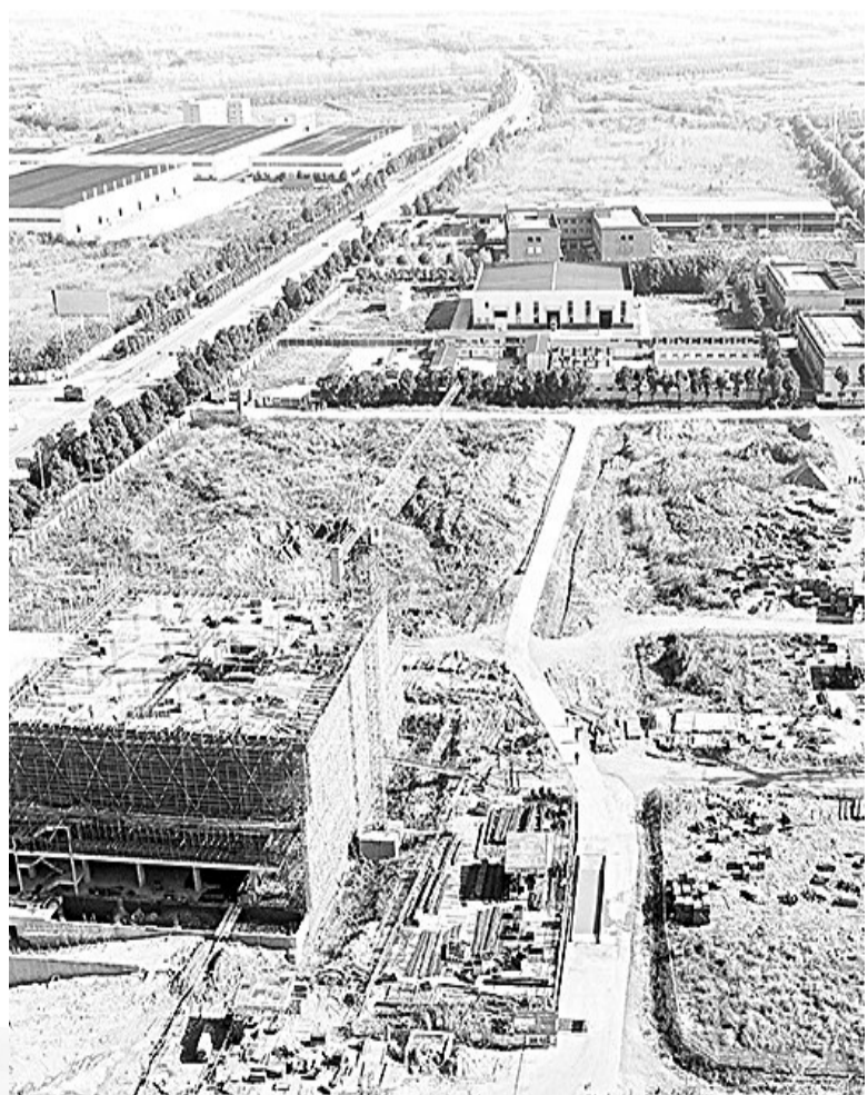
水产科技项目建设现场。
