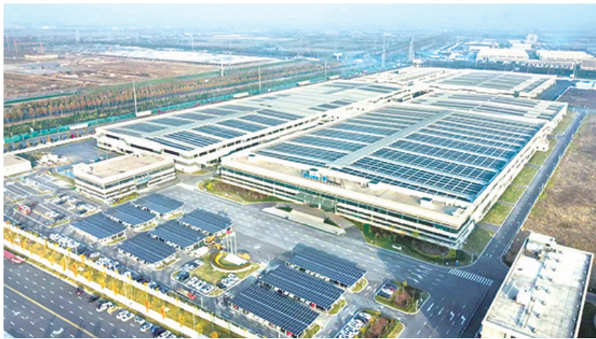
湖北美的洗衣机有限公司2号楼屋顶光伏项目鸟瞰。
