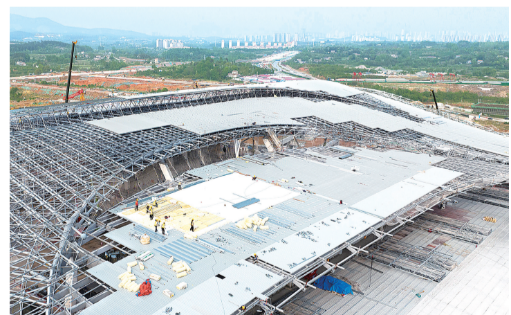
荆门西站站房进入室内装修阶段。(荆门日报 张彩云 摄)
