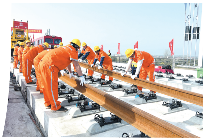
工人正在进行铺轨作业。
