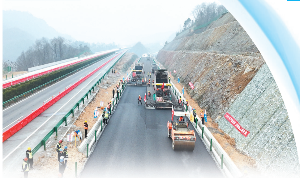
4月12日,在宜昌市全福河村境内,作业人员正在操作摊铺机进行AK0+230-AK0+534段沥青中面层试验段摊铺作业。
