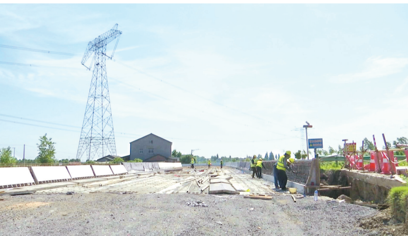
郢六线是江陵县东西向的一条重要交通运输通道,于2023年12月开始进行改建施工。目前,项目建设进展顺利,预计今年底可建成通车。(杨小红 摄)
