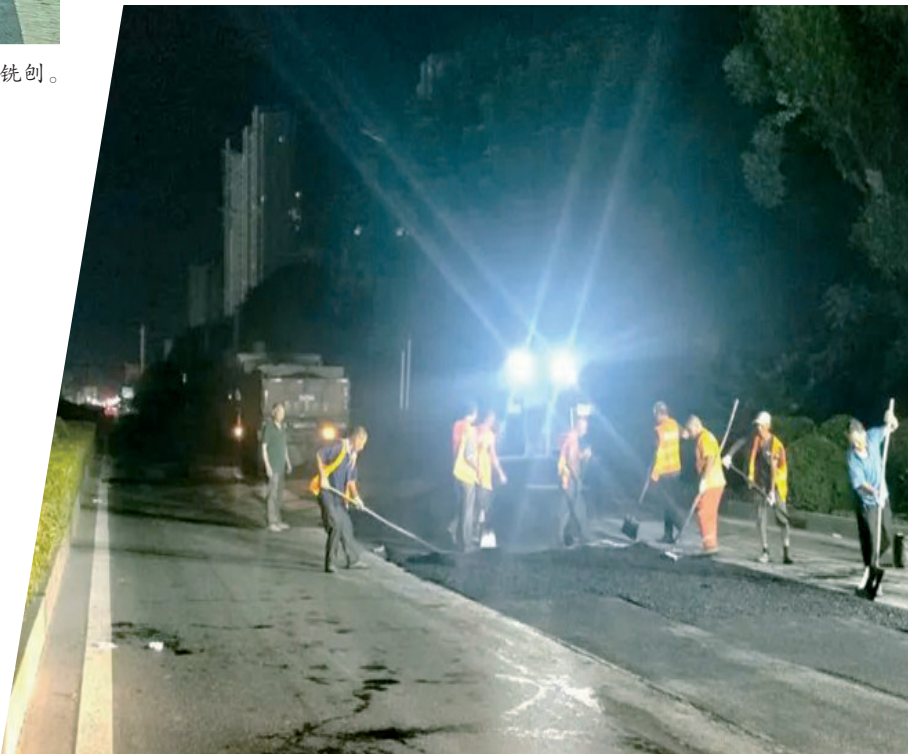
夜间沥青摊铺。
