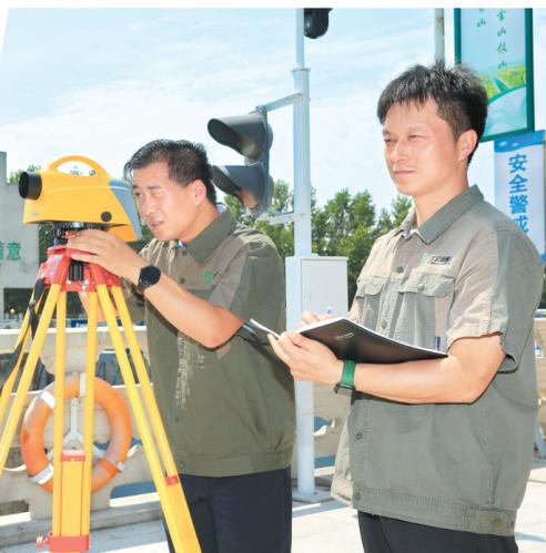
日前，在江汉运河荆州龙洲船闸旁，湖北省江汉运河航道管理处工作人员冒着高温用电子水准仪测量闸门跳动量，全力以赴做好运河通航运行维护工作。
