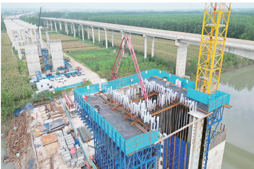
松西河特大桥主墩“0号块”浇筑现场。(记者 柯以鹏 摄)
