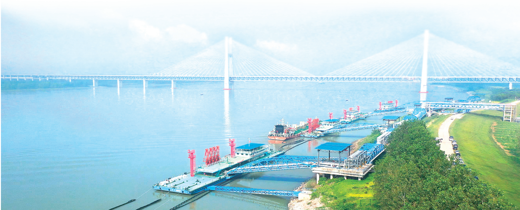
航拍湖北港口江陵石化码头。
