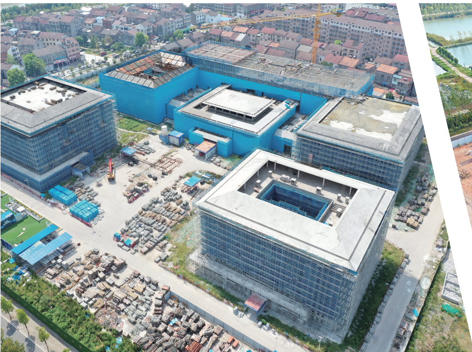
截至8月26日,荆州城发颐养中心(老年大学)主体场馆全部封顶,转入室内装修、植被绿化及道路建设阶段。 该项目总建筑面积3.7万平方米,东临草郊路、西为规划中的草庄路,计划于2025年初全面交付。项目建设包括主体教育中心、体育馆、老年公寓等,包含老年多功能教室、会议和多功能报告厅、行政办公区域。 (记者 梅闻 摄)
