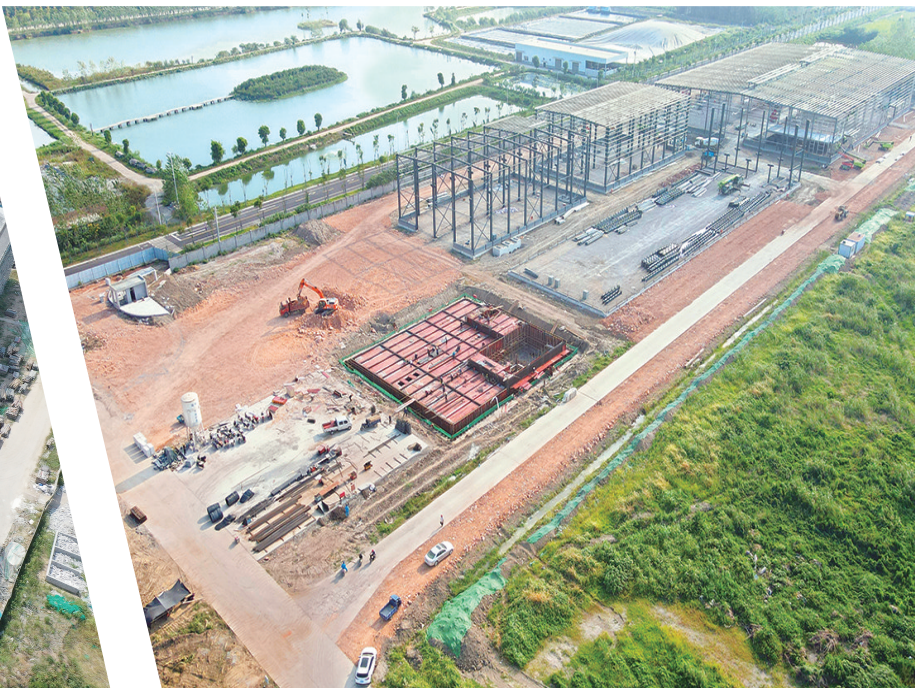
日前,金茂源(华中)表面处理循环经济产业园定制厂房项目进入主体结构施工阶段,计划于今年10月份交付使用。 为满足入园企业特定需求,园区为企业“量体裁衣”建设定制厂房。首批定制厂房面积约1.42万平方米,总规划占地面积约4万平方米。 (记者 潘路 通讯员 朱敦银 摄)
