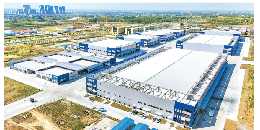
9月24日,航拍中国供销·荆州智慧冷链产业园,一排排仓储厂房颇具规模。今年5月上旬,该产业园一号冷库投产,进入试运营阶段,截至目前,冷库总吞吐量8000吨,总产值3.2亿元。(记者 张梦瑶 摄)
