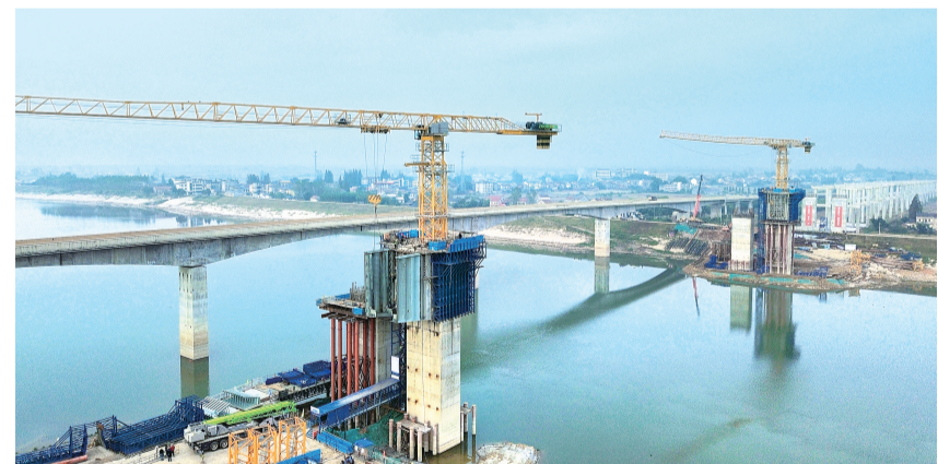
松西河特大桥施工现场。
