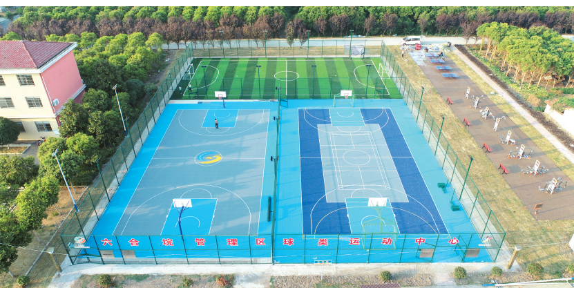
日前,六合院管理区球类运动中心竣工。该工程是2024年湖北首全民健身双创工程项目,总投资180余万元,占地面积约4000平方米。工程包括标准篮球场2个、五人制足球场1个、健身区1个。(田艳华 摄)
