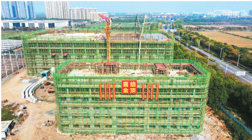
日前,位于荆州高新区的金久绿色新型材料包装大楼封顶,主体配套工程初现雏形。该项目建成后,主要生产各类真空保鲜包装,将有效推动我市新型包装材料绿色环保转型升级。(梅园 肖娟 朱迪 摄)
