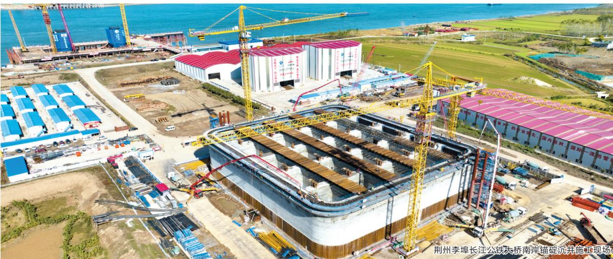
荆州李埠长江公铁大桥南岸锚碇沉井施工现场。
