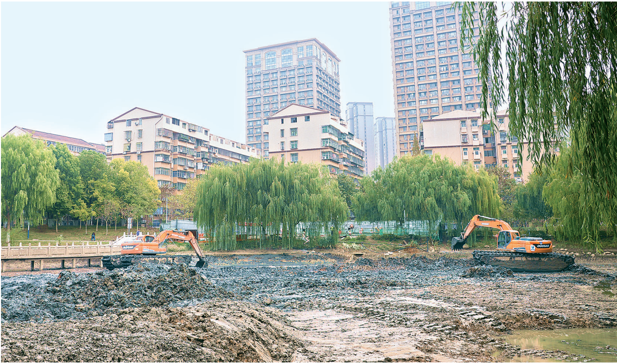
近日,在沙市区塔桥花园节制闸排污口污水治理工程现场,数台挖掘机和运输车来回穿梭,对荆襄内河河道进行清淤疏浚。
