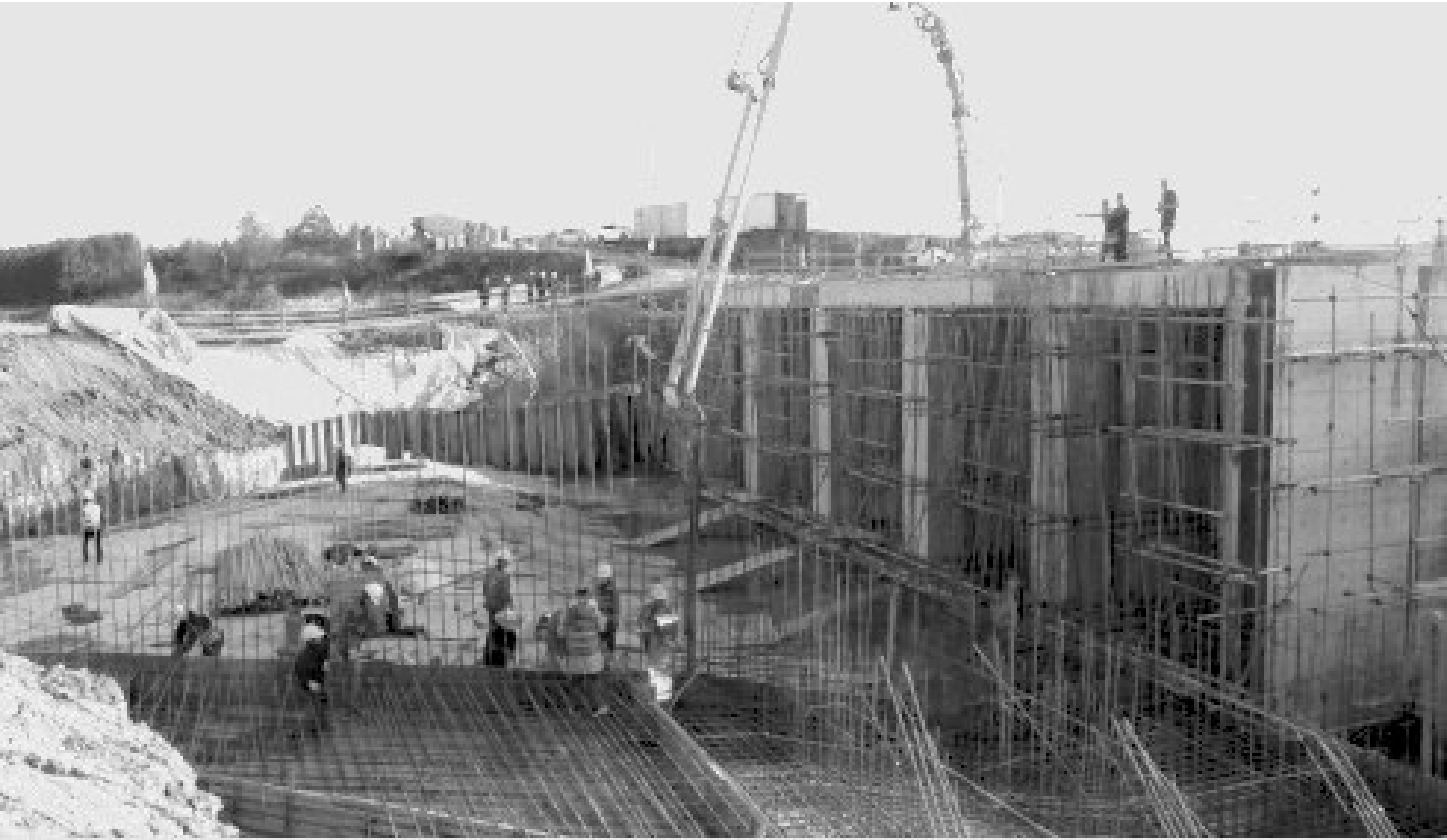
火热的项目建设现场。
