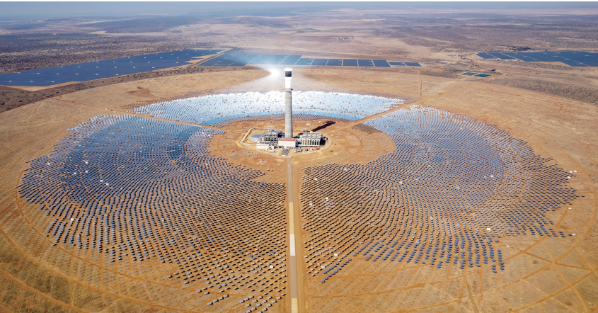
这是2024年8月20日在南非北开普省拍摄的由中国电建集团山东电建三公司承建的南非红石100兆瓦塔式熔盐光热电站项目。该项目是撒哈拉以南非洲首个塔式熔盐光热电站项目,也是南非最大可再生能源投资项目之一。(新华社 发)
