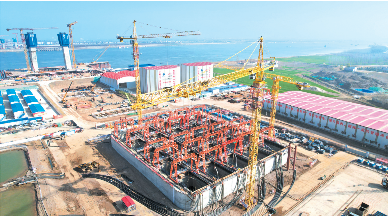
荆州李埠长江公铁大桥南岸锚碇沉井下沉施工现场。
