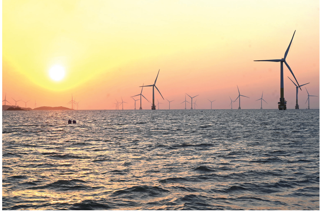
2025年1月19日拍摄的福建莆田平海湾海上风电场(无人机照片)。(新华社 发)
