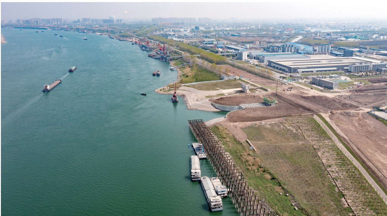
4月1日，在荆江大堤盐卡闸建设现场，工人正在对闸室启闭机房进行立柱浇筑。
