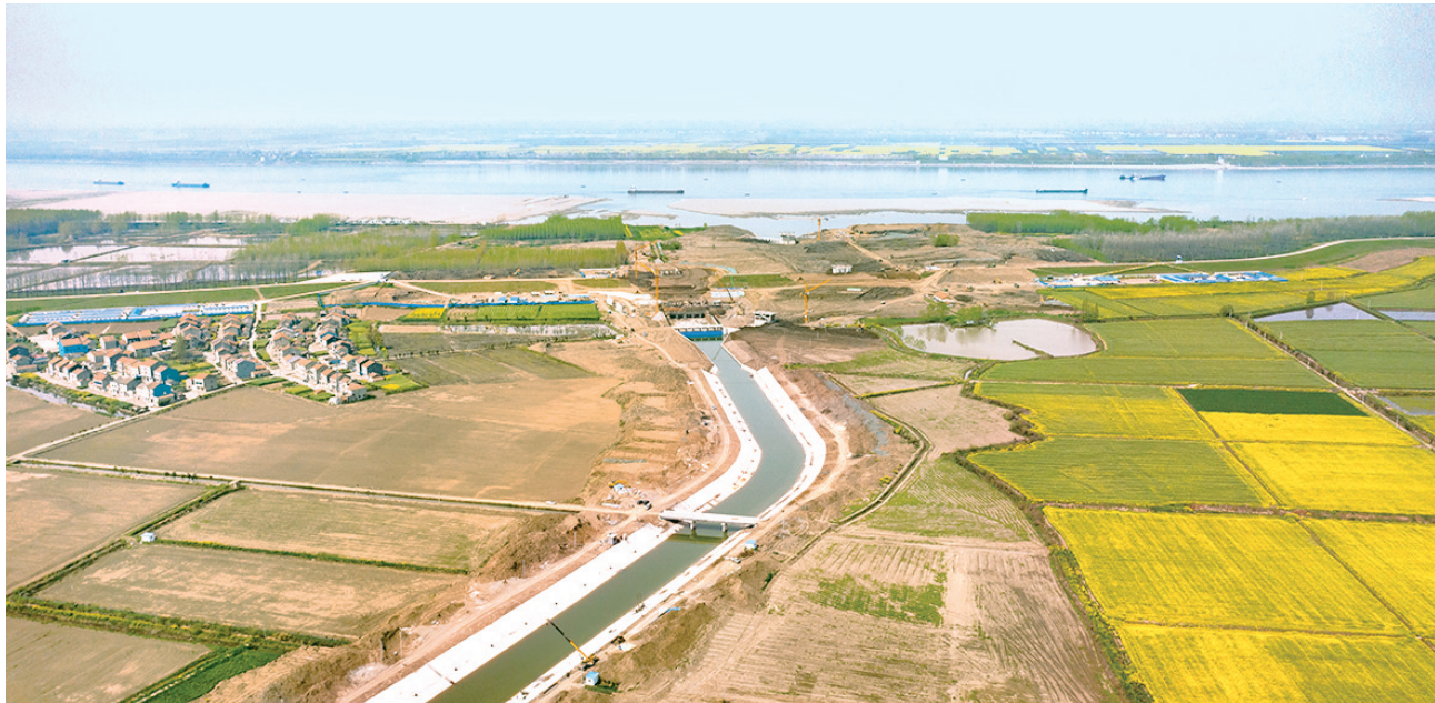
航拍白柳引水闸新建工程建设现场。
