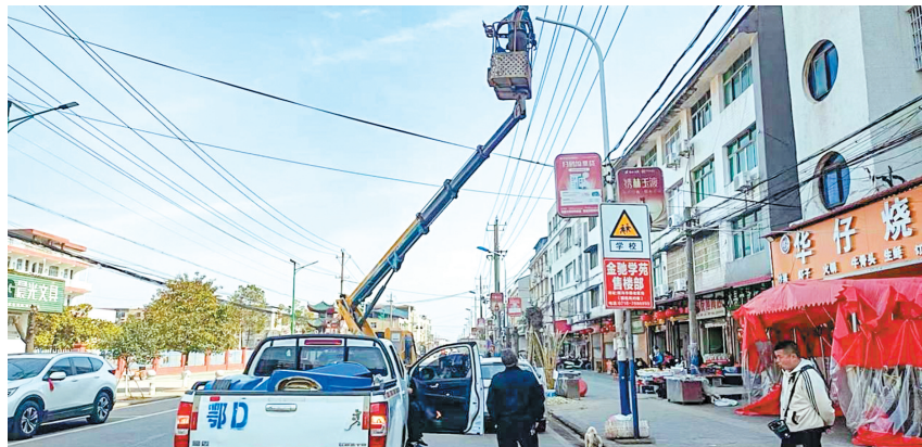
近日,横沟市镇镇区老旧路灯改造工程完工,新路灯正式“上岗”,为居民夜间出行带来便利。(通讯员 李永尚 邹立力 摄)
