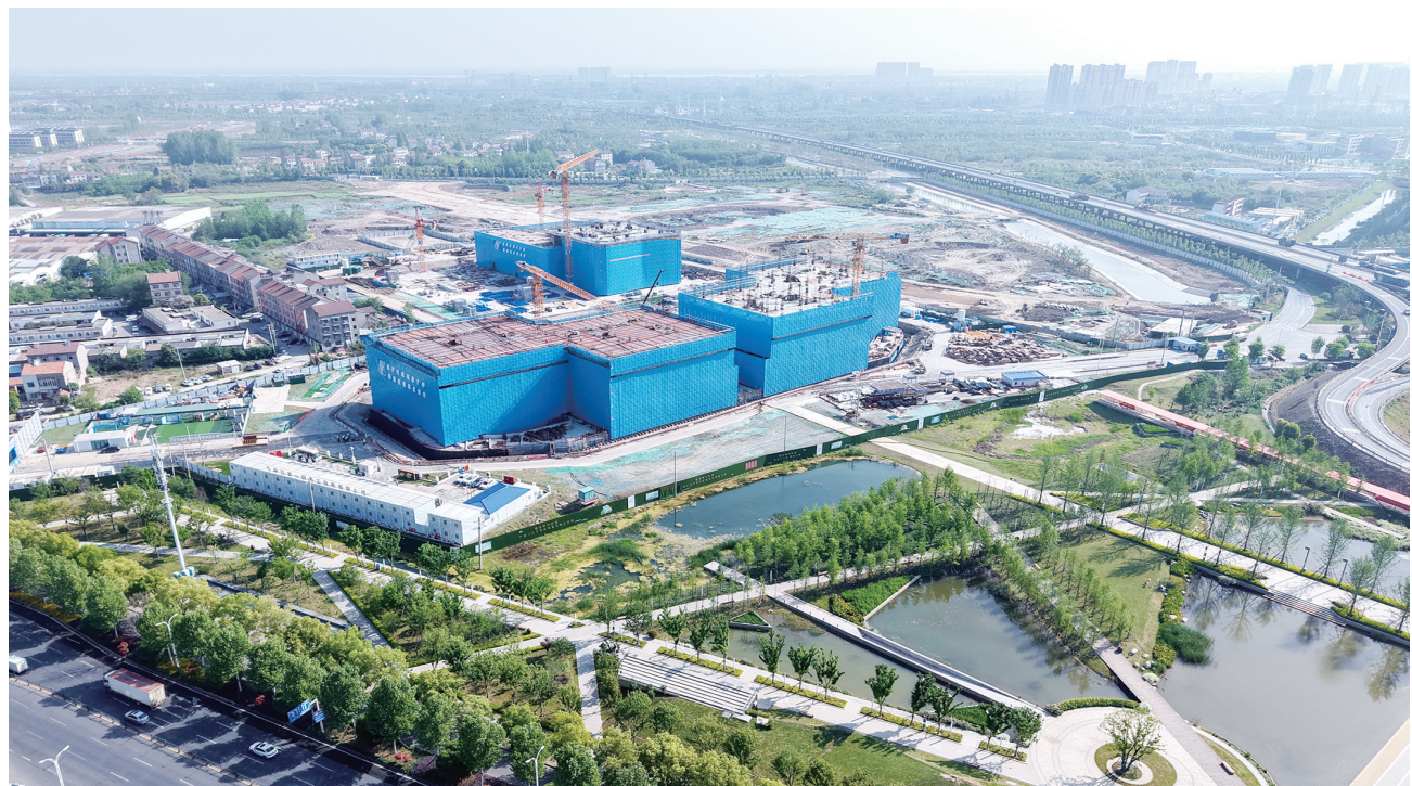
建设中的荆州新城产业孵化中心(东塔)和产业创客中心。
