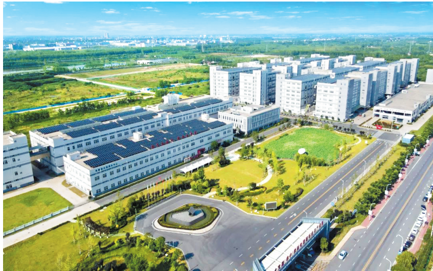
鸟瞰金茂源(华中)表面处理循环经济产业园。
