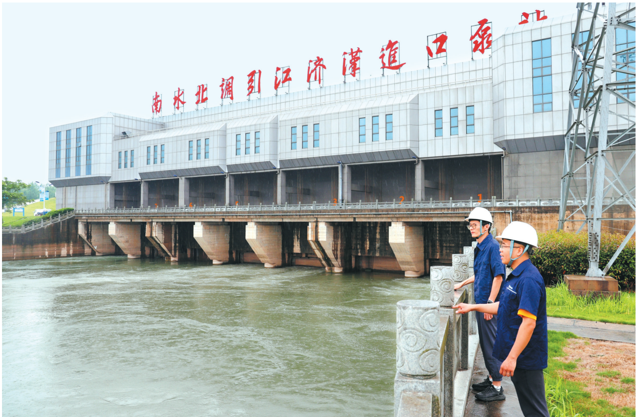
泵站安排专人24小时值守,密切监控设备运行状态。
