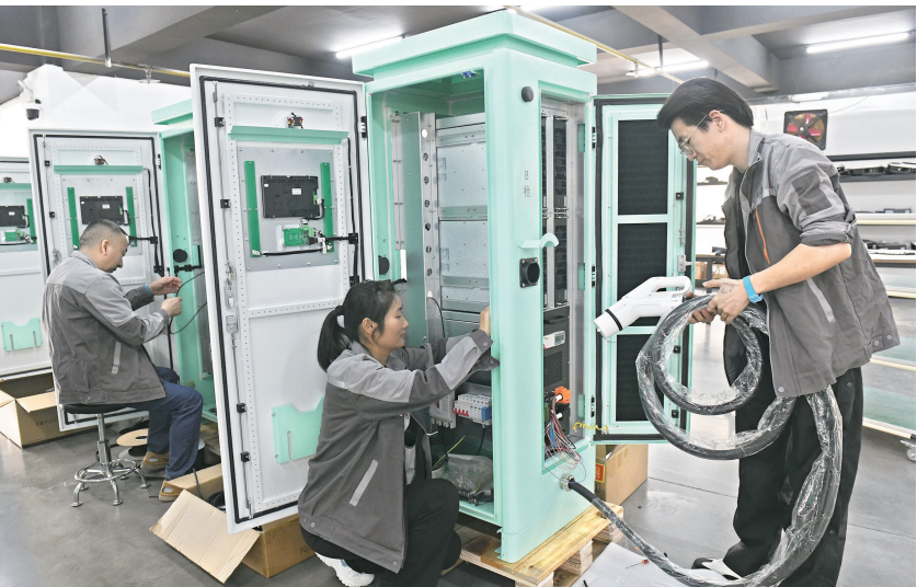
近日,湖北恩普能源技术有限公司生产车间内,工人正抓紧安装一批柜式充电桩。该公司主要开展新能源技术研发、电动汽车充电基础设施运营、输配电及控制设备制造等业务。近年来,该公司一手抓品牌建设,一手抓技术研发,实现了产销两旺。(梅闻 摄)
