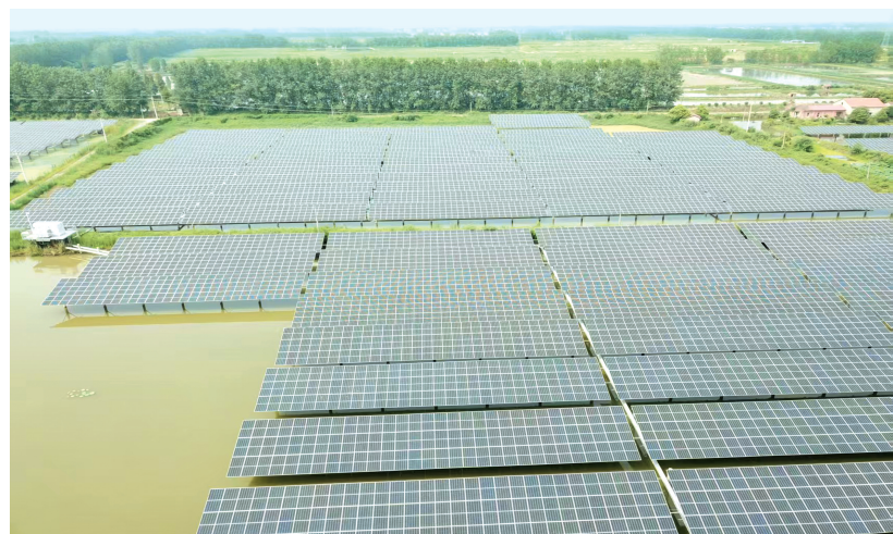
扁担湖渔场“渔光一体”项目。
