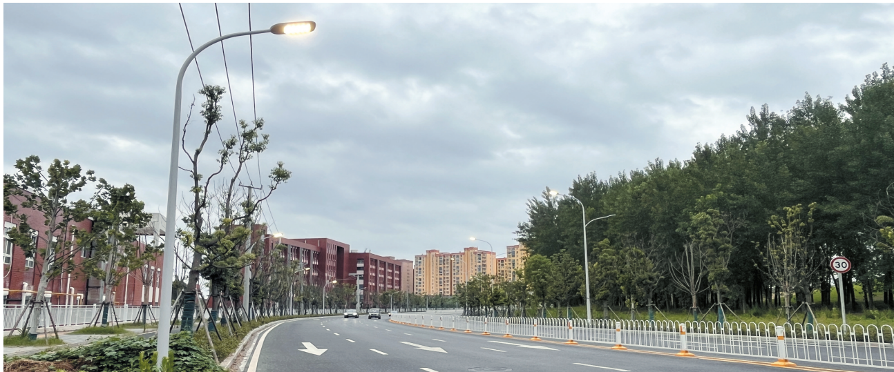
荆江大道美晟金属材料公司至荆沙铁路桥段45盏路灯亮灯。
