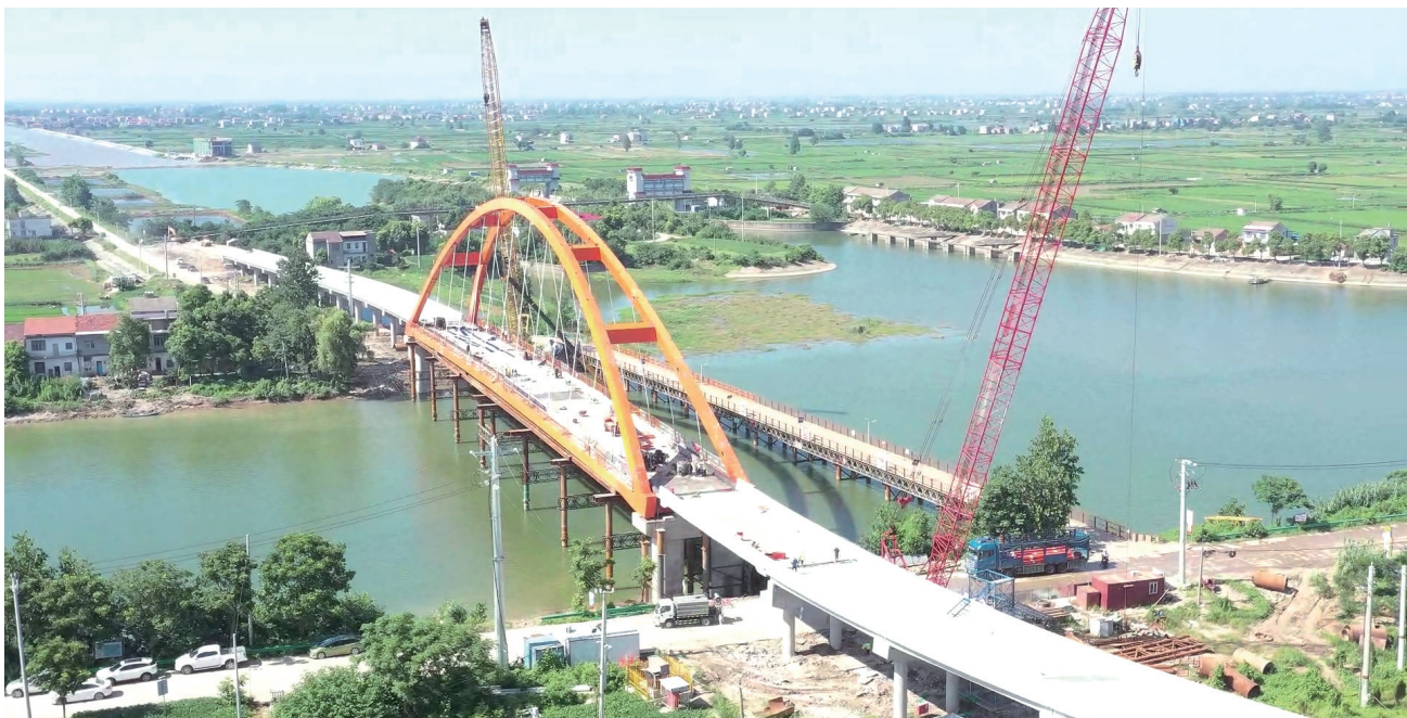
宦子口桥工程建设进入尾声。通车后,四湖总干渠两岸老区人民往来主要依赖渡船将成为历史。
