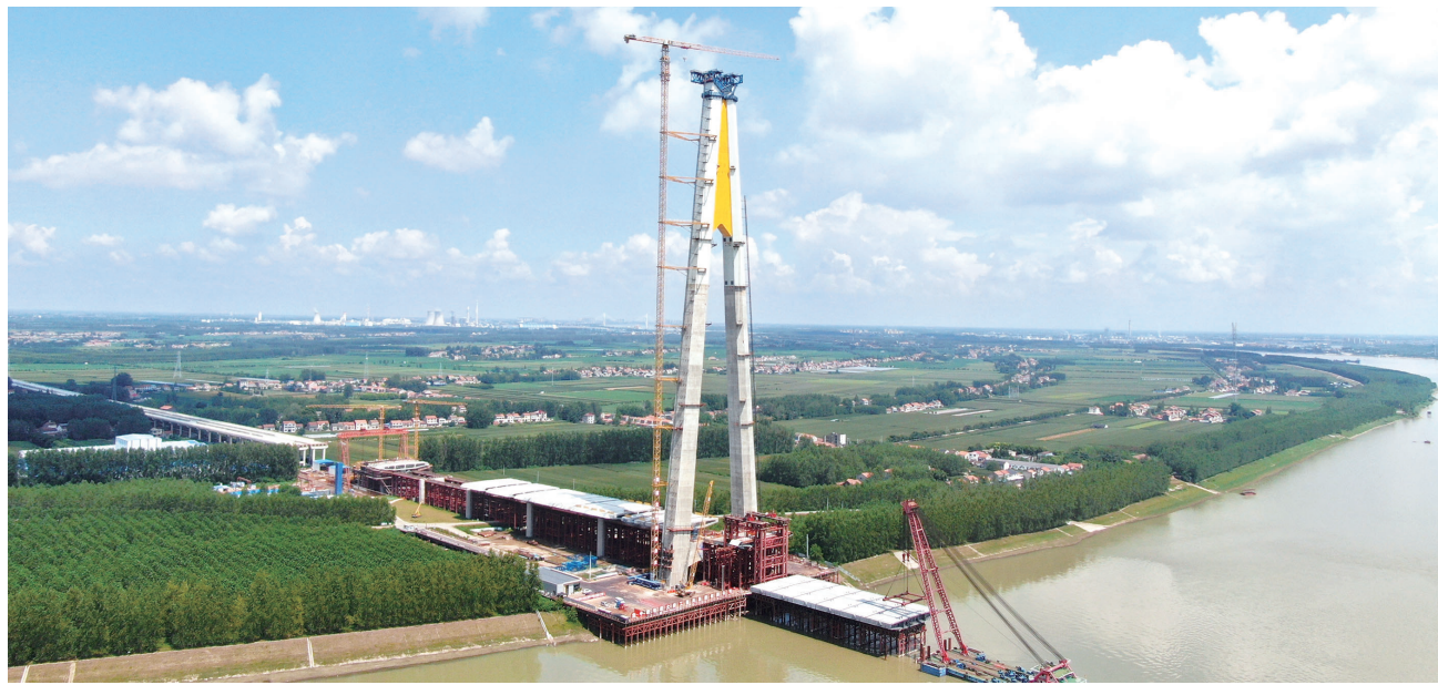
鸟瞰观音寺长江大桥江陵侧主桥及首节钢-UHPC组合梁。(杨佳庆 摄)
